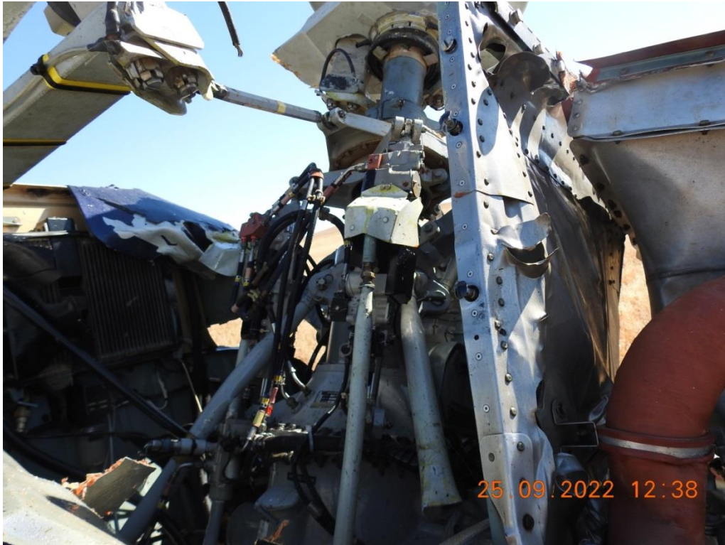
Зураг 34. редуктор болон даах сэнсны хүчлэх бэхэлгээнүүдийн эвдэрсэн байдал
